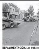
REPAVIMENTACIÓN. Los trabajos tendrán una duración de 45 días.
