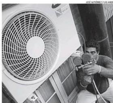
FUNDAMENTAL. Ventilación adecuada y limpieza de filtros.
