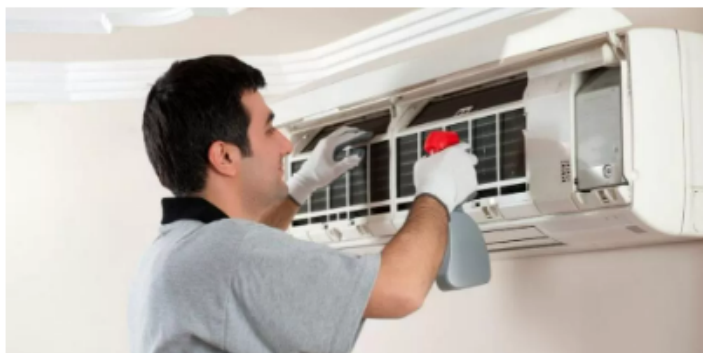
LIMPIAR LOS FILTROS. Es fundamental para no contaminar el aire.
